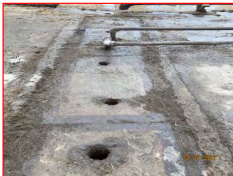
ภาพที่ 2.2-24 รางระบายน้ำทิ้งไปยังบ่อบำบัด ของโรงงานน้ำตาล
