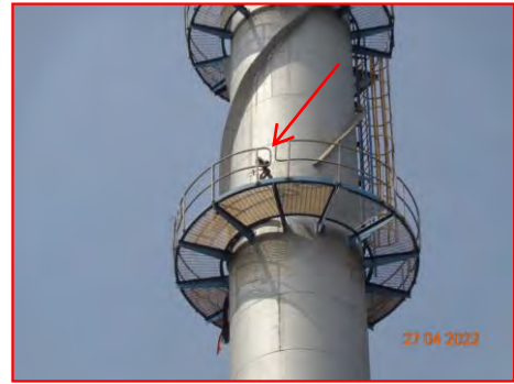
ภาพที่ 2.2-2 ระบบตรวจวัด Oxygen Analyzer Sensor
