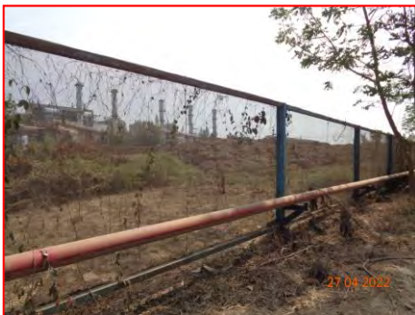
ภาพที่ 2.2-18 โครงสร้างเหล็กติดตามข่ายดักฝุ่น ล้อมรอบพื้นที่ลานกองเถ้า
